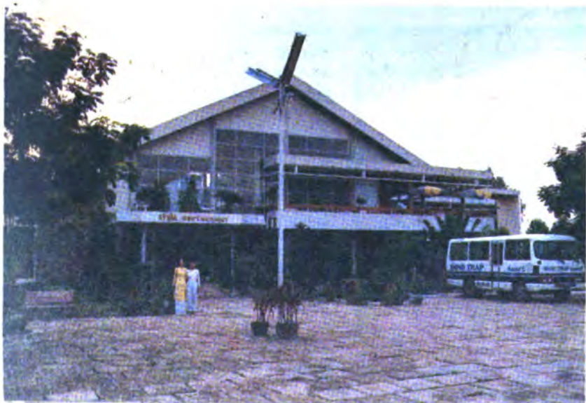
NHÀ HÀNG KỶ HÒA
