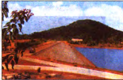
Đập hồ được xây dựng ở Vinh Sơn. Nhà máy thủy điện - Bình Định - Dự án chất lượng cao
