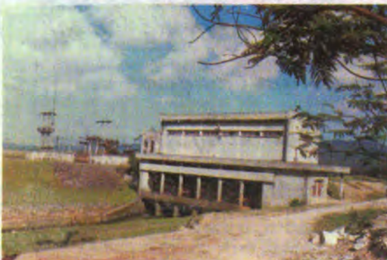
Trạm bơm Linh Cẩm
