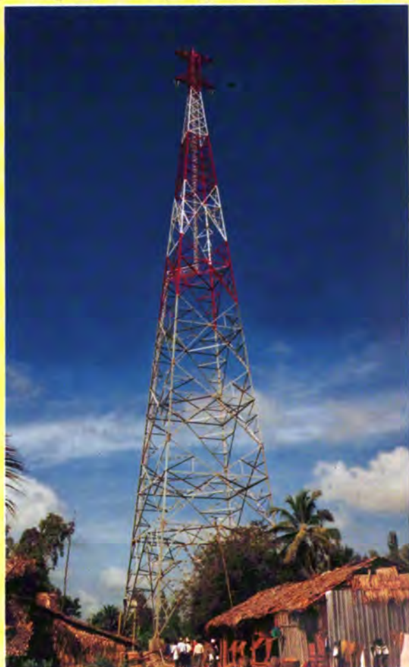
Cột vượt sông Hậu, cao 90m cấp điện cho Cù Lao Dung, huyện Long Phú, tỉnh Sóc Trăng (do công ty xây lắp điện 3 thi công)
