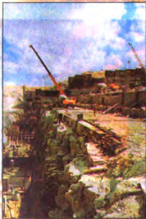
Đập tràn được xây dựng ở Sông Hinh. Nhà máy thủy điện tỉnh Phú Yên
