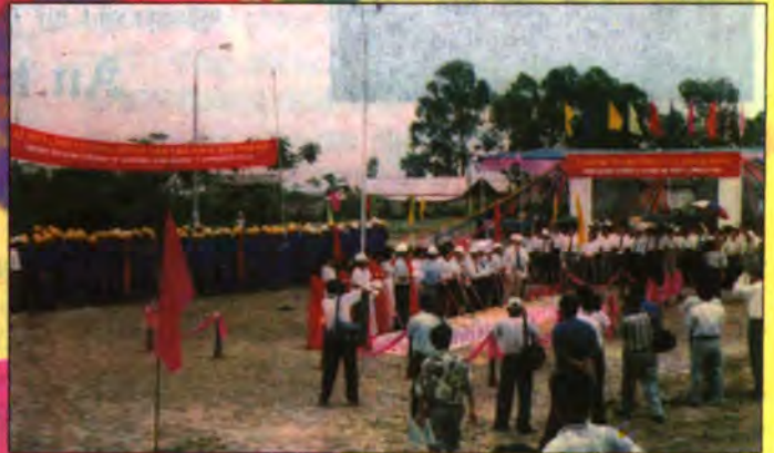
Lễ khởi công xây dựng gói thầu số I - đường dân phía Nam Cầu Bình do Công ty CTGT Hải Phòng làm chủ dự án
