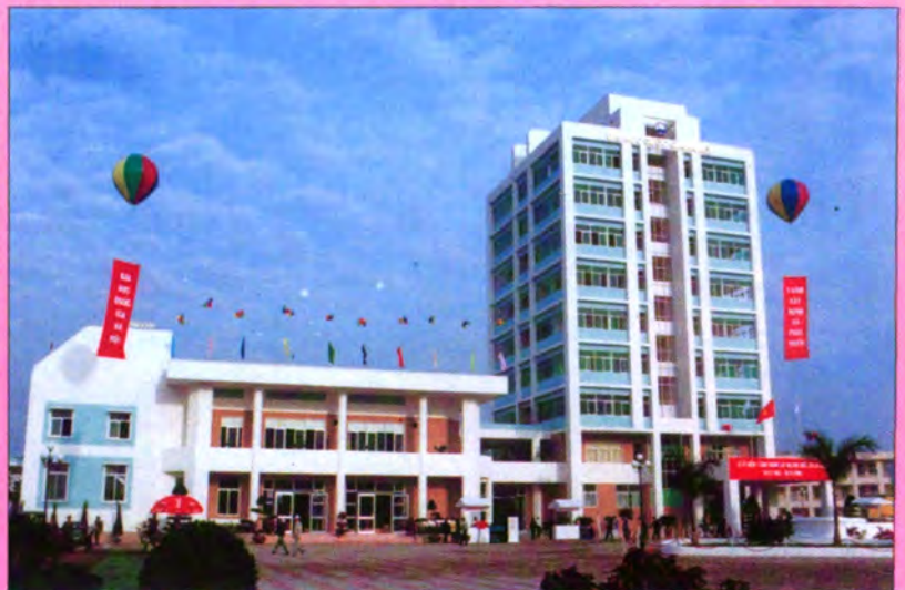
Nhà điều hành Trung tâm
