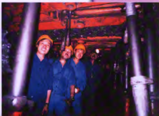
Viện trưởng Viện KHCN Mỏ cùng cán bộ kỹ thuật kiểm tra lò chợ chống giá thủy lực di động tại công ty than Hà Lâm.
