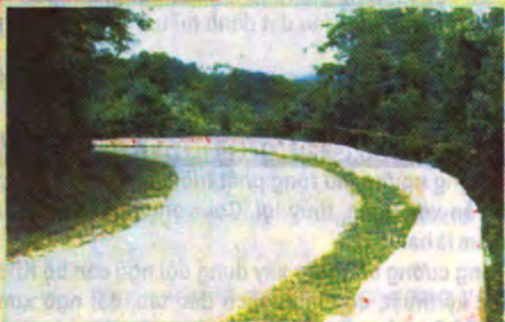
Hệ lan can phòng hộ cứng tại Đèo Áng Toóng đường tỉnh lộ 256 do Công ty thi công
