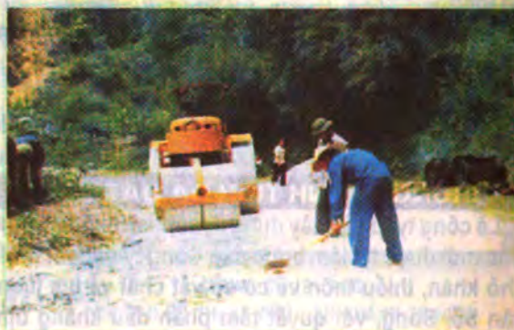
Rải nhựa km 79-80 đường tỉnh lộ 254 do Công ty thi công
