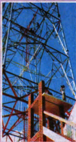
Thi công tháp ăng ten truyền hình
