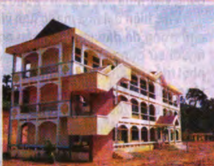
Công trình do Công ty thi công
