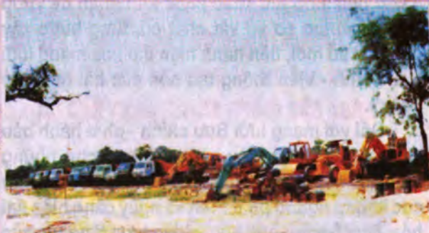
Thiết bị Thi công cơ giới
