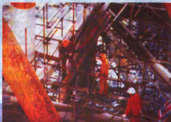
Sửa chữa giàn khoan biển
