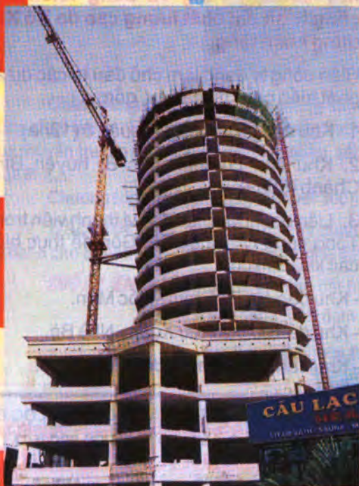
Công trình Trung tâm thương mại Hàng Hải - Do Công ty thi công
