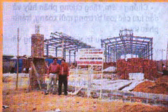
Thi công công trình Nhà máy Cơ khí
