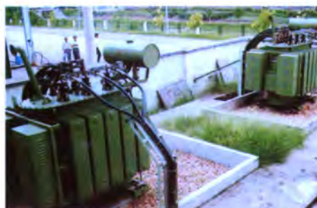
XÂY LẮP TRẠM ĐIỆN
