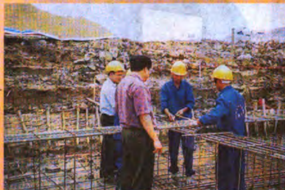
Thi công móng đường dây 500kW Nho Quan, Thường Tín
