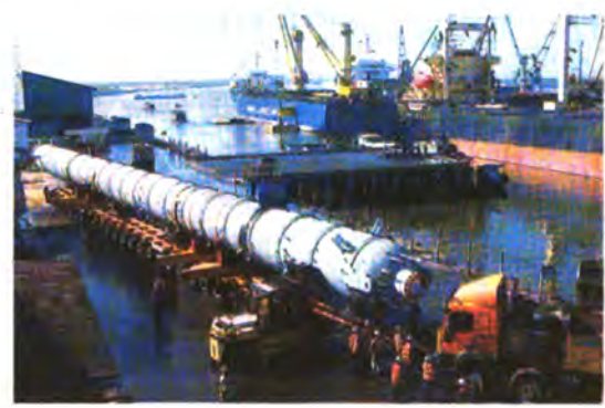
Vận chuyển tháp CO2 nặng 300 tấn, dài 60 mét phục vụ xây dựng Nhà máy Đạm Phú Mỹ
