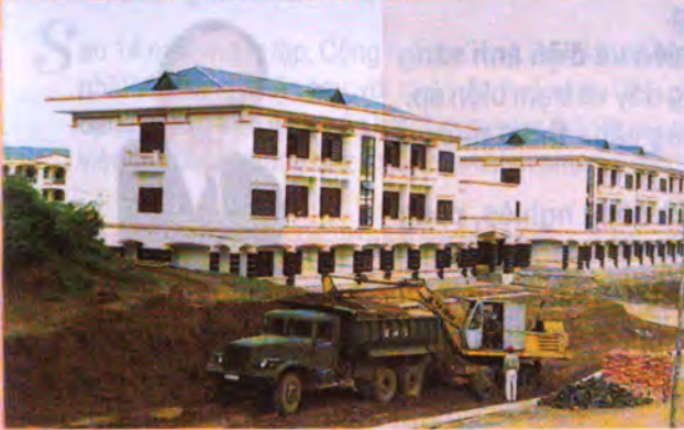
Trường Công nhân Kỹ thuật - Khu CN Dung Quất Công trình do Công ty thi công
