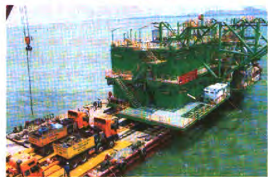
Vận chuyển các mô-đun gồm nhiều tổng đoạn nặng hàng nghìn tấn ra giàn khoan Ta-li-sman phục vụ khai thác dầu khí mỏ Nam Côn Sơn
