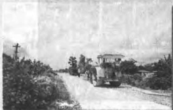
Sửa chữa đường bộ
