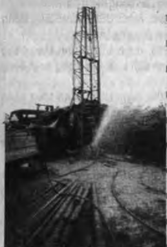
Thi công lỗ khoan địa chất thủy văn tại công trình KCN Bắc Thăng Long - Hà Nội
