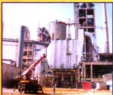
Thi công lắp đặt thiết bị nhà máy xi-măng
