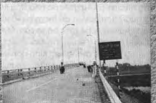
Cầu vượt Đại Đình - một trong những cây cầu do Đoạn quản lý
