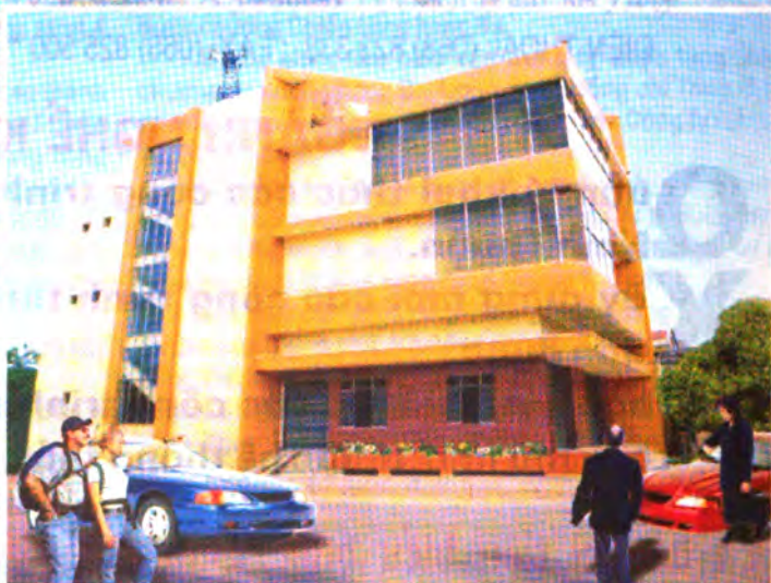
Nhà trạm Điện Thoại Thủ Thiêm
