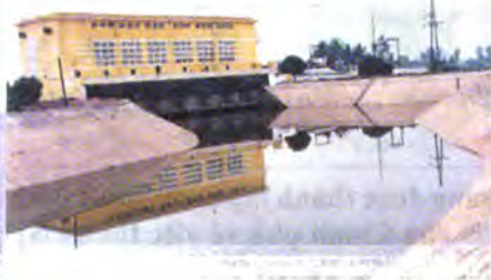
Trạm bơm điện Nhân Hòa
